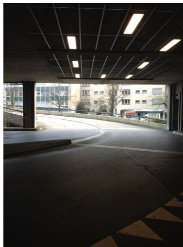
Auffahrt (Schnecke) in das Post Parking.
