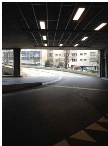
Auffahrt (Schnecke) in das Post Parking.
